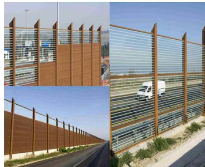
Акустические характеристики панели ШПЖ-5/6 Индекс изоляции воздушного шума – от 15 до 38 дБа.
